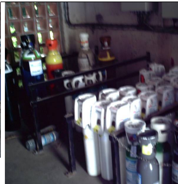
Figure 32 : Exemples de stockage (rangement séparé et obus arrimés)
