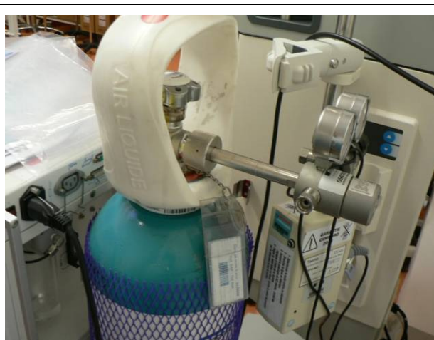
Figure 13: Détail du branchement du détendeur
