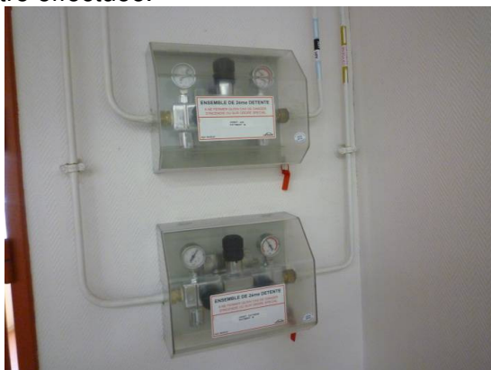
Figure 36: exemple de régulateur situé à l'entrée du service
