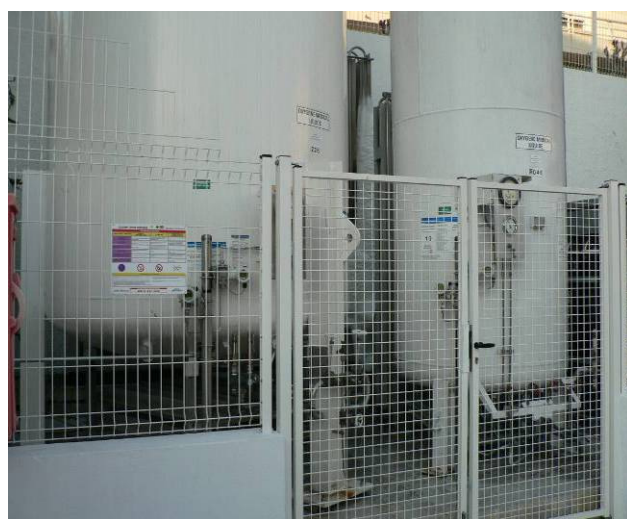
Figure 27: Exemple d'accès sécurisé à la centrale
