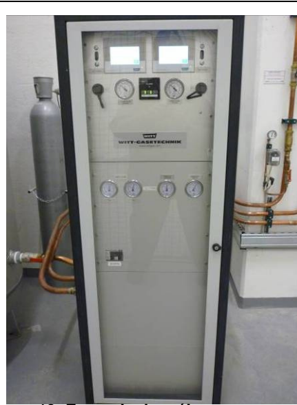
Figure 10: Exemple de mélangeur
