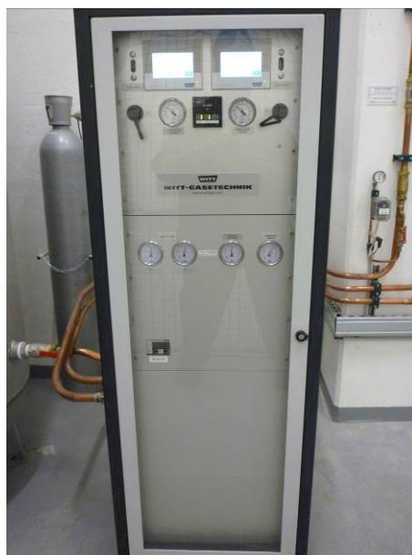
Figure 35: exemple de mélangeur
